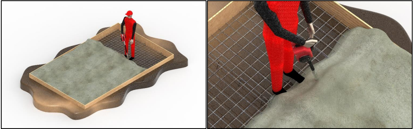
Abbildung 6: Arbeitsweise bei der Betonverdichtung.
